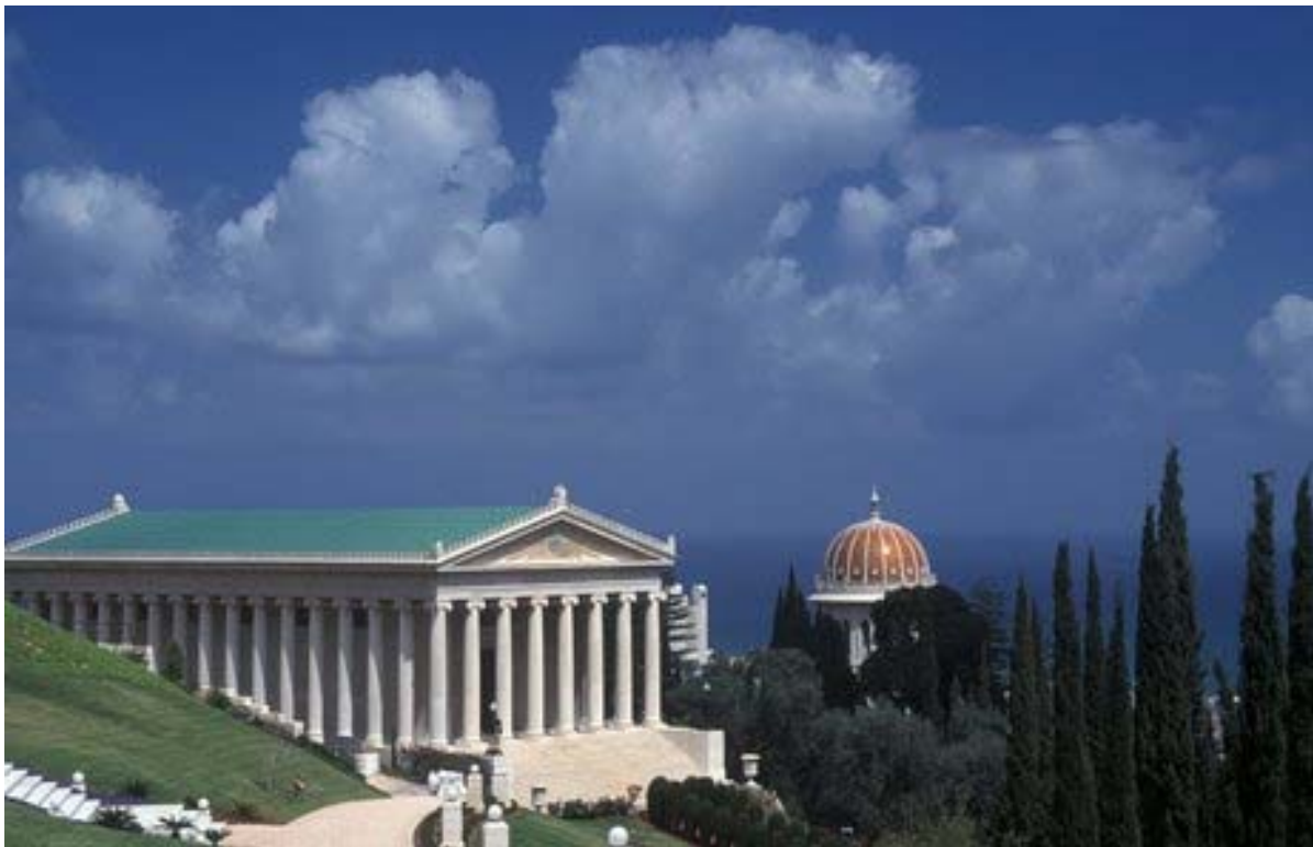
El Edificio de los Archivos Internacionales
